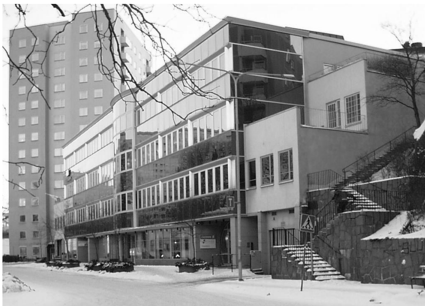
Figur 19. Byggnad som bl. a. inhyser ett brevbärarkontor i Solna. Foto: Stig-Inge Gustafsson.
