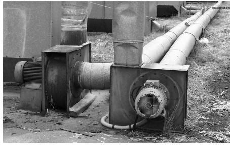
Figur 11.54: De två tömningsfläktarna som leder spån från filtren till cyklonen. Foto: Stig-Inge Gustafsson
