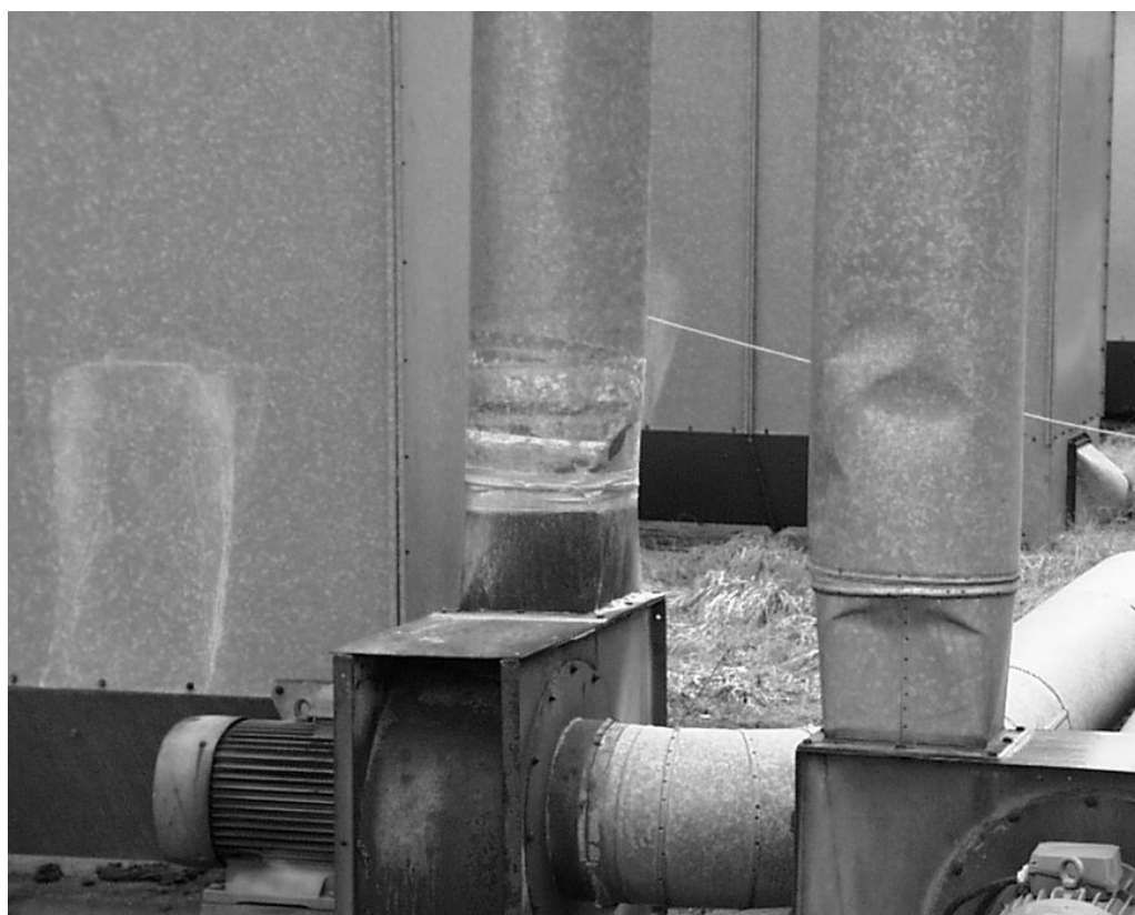
Figur 157. De två tömningsfläktarna som leder spån från filtren till cyklonen.
